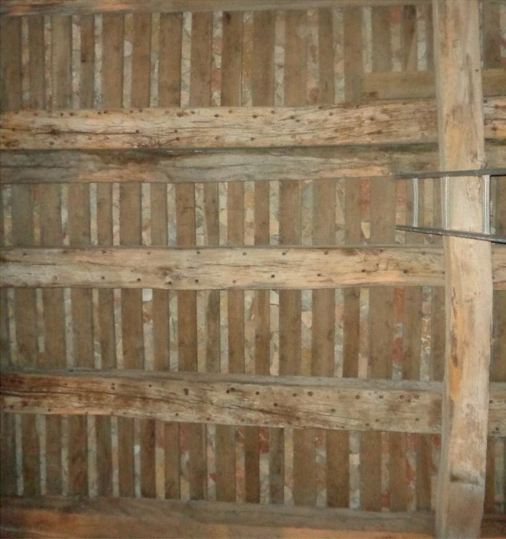
Photo 14 : chevrons retournés où l'on distingue les trous des chevilles de maintien des voliges de la couverture d'origine.
